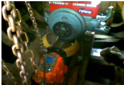
Gambar 4. Peletakan dan pemasangan mesin pada pondasi mesin
