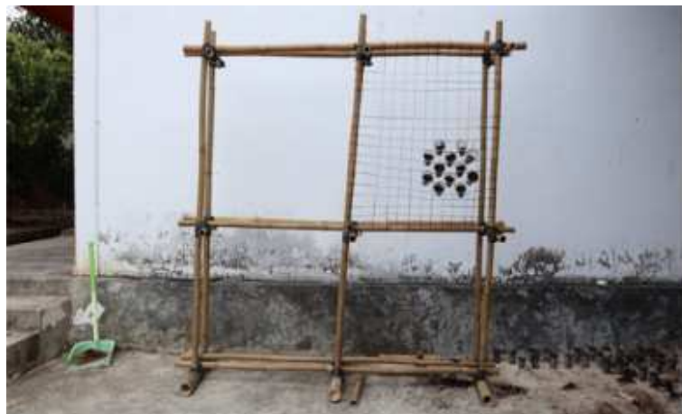
Gambar 3. Pemasangan kawat di modul green panel .
