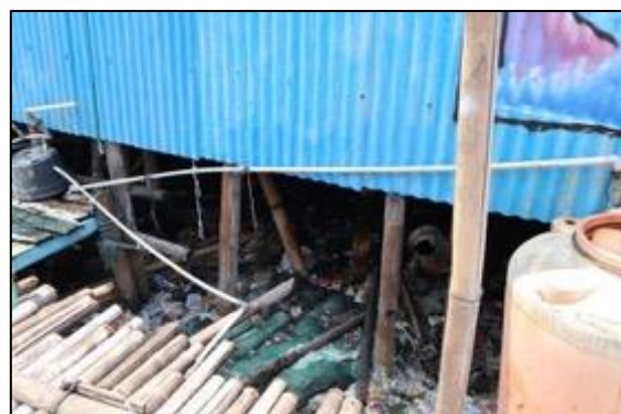
Gambar 17. Genangan Air Bercampur Sampah di Bawah Rumah Panggung yang Tidak Termanfaatkan
