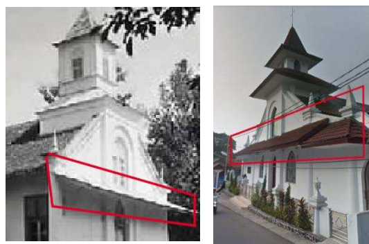
Gambar 19. Bagian atap depan Gereja yang sudah mengalami perubahan
