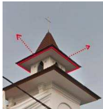
Gambar 15. Perubahan atap yang terjadi dibuat lebih lebar agar tidak tempias pada menara Lonceng Gereja (2018)
