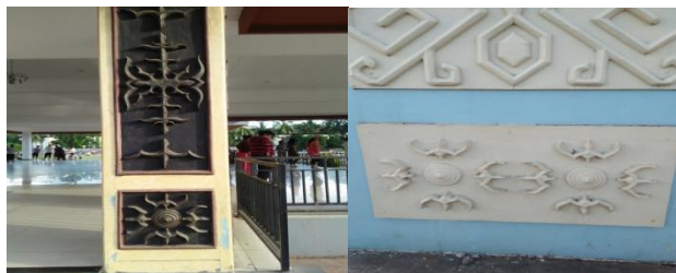
Gambar 13. Nunusaku Pada Tiang Dan Pagar Lapangan Merdeka Kota Ambon
