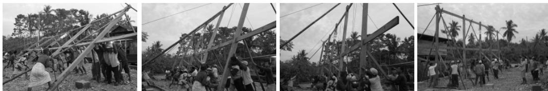
**Gambar 18.** Proses Pendirian Rumah Panggung secara Gotong-royong. Keterangan gambar : a. jejeran tiang-tiang sementara diangkat untuk didirikan, b/c. jejeran tiang sedang didirikan, dan d. jejeran tiang tegak berdiri.
