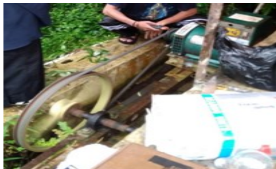
Gambar 4. Implementasi pada Generator B
