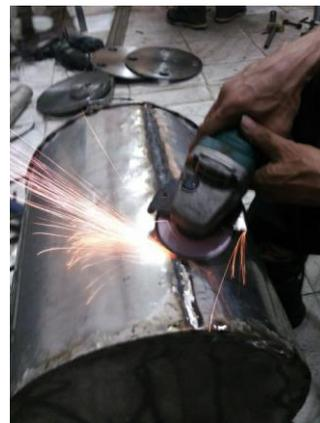
**Gambar 29.** Penghalusan pada permukaan sambungan lasan panci
