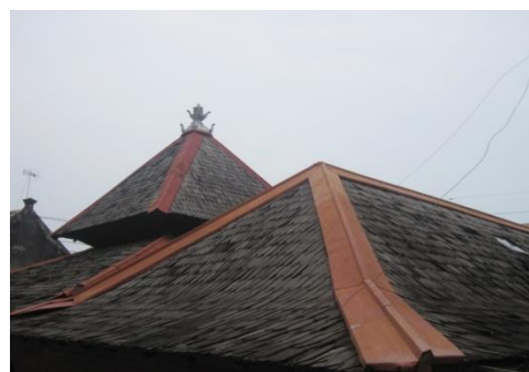
Foto 5. Atap Sirap Masjid Merah (Sumber: Dok. Pribadi, 2011)
