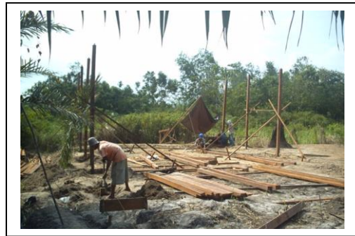
Gambar 2: Pekerjaan Pembuatan Work Shop
