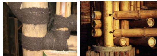
Gbr. 2. Sambungan konstruksi bambu. Kiri: sambungan tali ijuk. Kanan: sambungan baut
