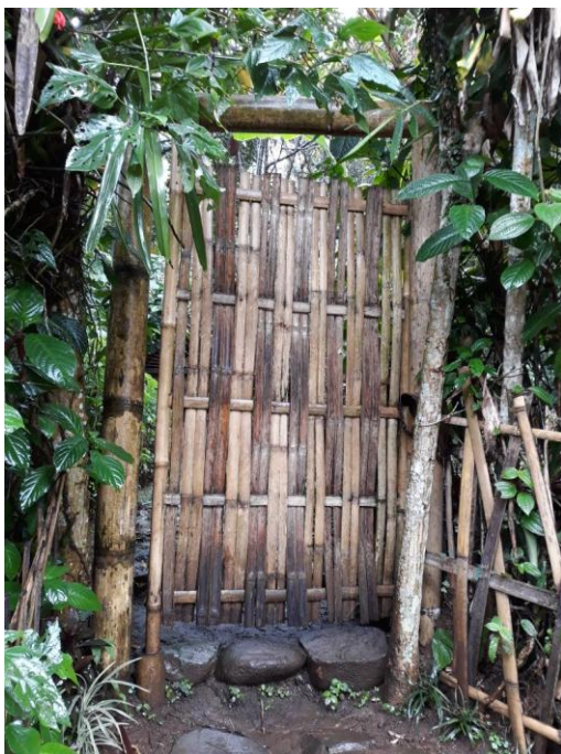
Gambar 2. Pintu Gerbang Rumah Adat Kampung Cikondang Kabupaten Bandung (Dokumentasi Penelitian, 2018)
