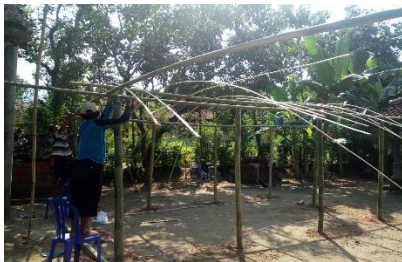
Gambar 1. Pembangunan green house oleh warga di salah satu titik lokasi
