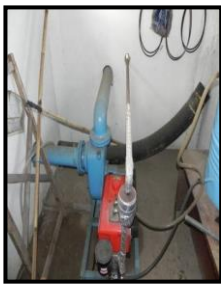
A. Mesin Pompa
