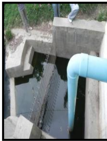
C. Pipa penyedot air
