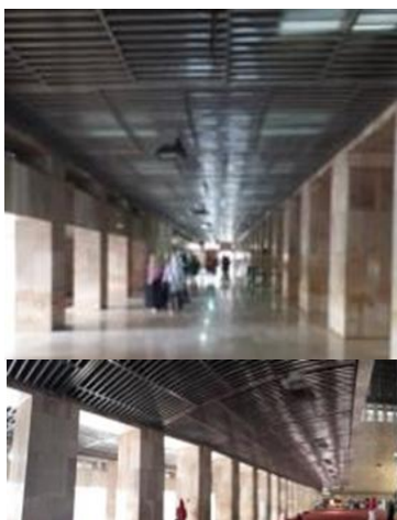
Gambar 4. Bentuk bukaan (pintu) persegi diruang shalat dan koridor lebar sehingga terhindar dari tempas hujan
