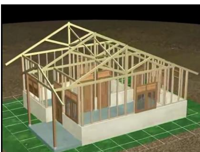
Gambar 10 Tahapan pemasangan kuda-kuda
