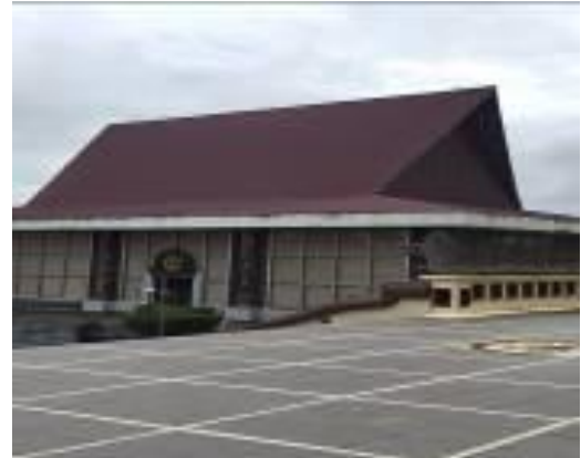
Gambar 3. Atap bangunan altar utama tempat patung Buddha tidur diletakkan yang mengadopsi atap rumah daerah Kalimantan Selatan.
