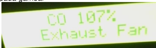
Gambar 9. Monitor keadaan udara dalam ruangan sangat buruk.
