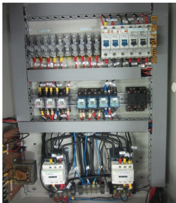
Gambar 7. Tampilan Panel Simulasi ATS dan AMF
