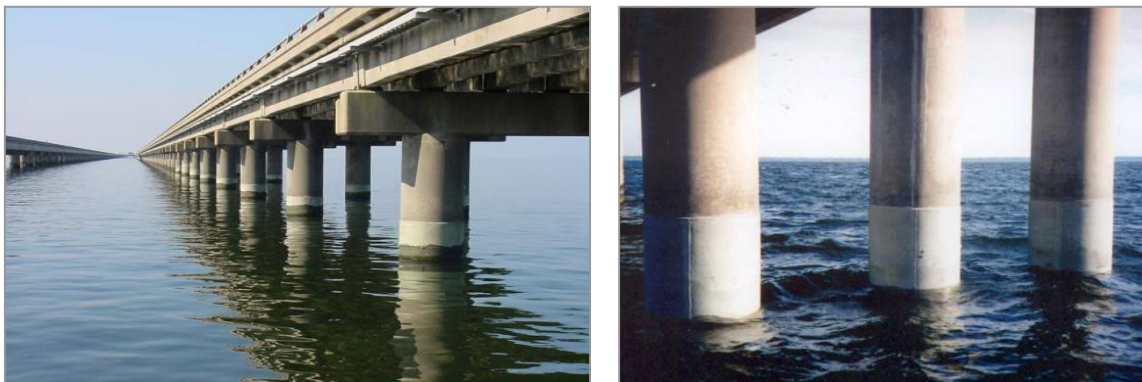
Gambar 2. Kondisi pondasi tiang bangunan dermaga RDMT setelah perbaikan
