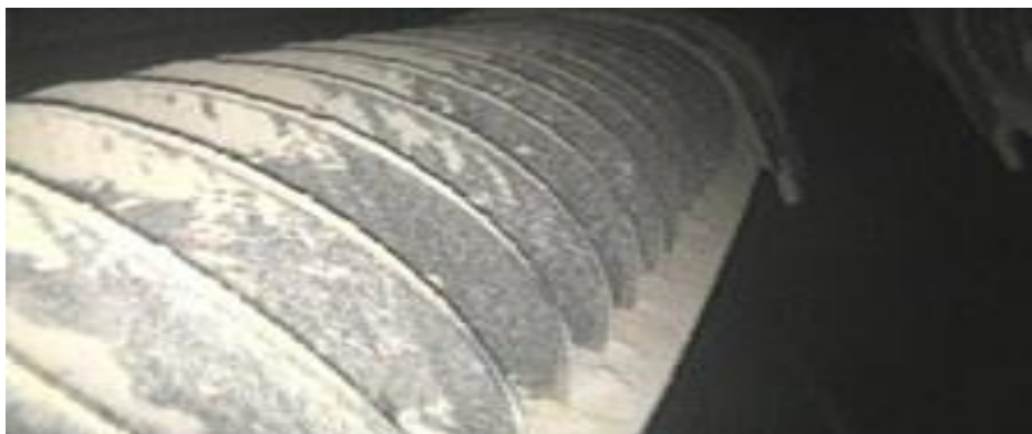
Gambar 5. Ash Deposit pada Economizer Tube Boiler .
