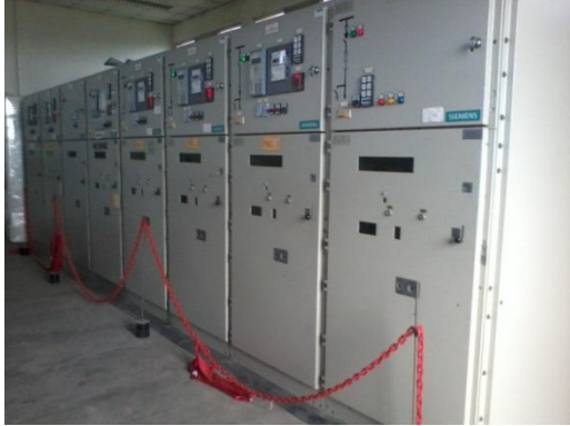
Sumber : GI Purbalingga Gambar 1. Kubikel 20 KV
