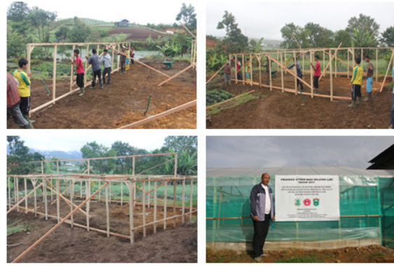
Gambar 3. Pembangunan Screen House untuk Penangkaran Benih Kentang
