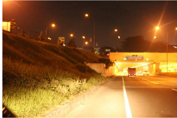
■ Gambar 3. Tampak terowongan Pasar Rebo dua arah yang dipisahkan dengan dinding pemisah.
