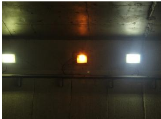
■ Gambar 5. Pemasangan lampu HPS dan LED di terowongan Pasar Rebo
