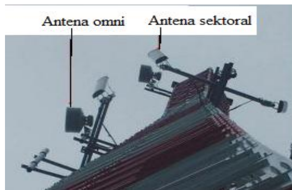
■ Gambar 2. Susunan antena pada BTS Indosat
