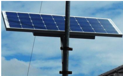
Gambar 3.5 Panel Surya 85 W [Sumber : Data Pengujian]
