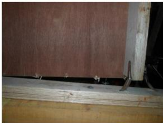
(d) Mudsill Failure
