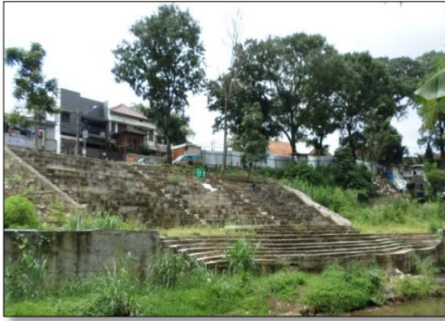
Gambar 4. Tribun Lereng Beton Restorasi Sungai Cikapundung
