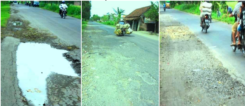
Gambar. 4 Ruas Jalan Rusak di Sekitar Wilayah Padat Penduduk di Kecamatan Plemahan
