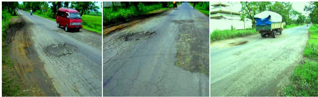
Gambar. 3 Ruas Jalan Rusak Di Sekitar Pusat Pertumbuhan Ekonomi di Kecamatan Plemahan
