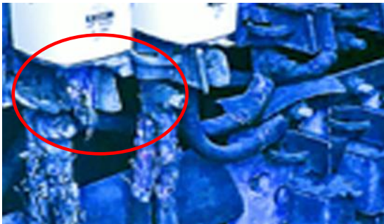
Gambar 4. Sepatu Kabel Rusak
