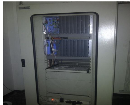
Gambar 14. RTU dengan Media Komunikasi Fiber optic
