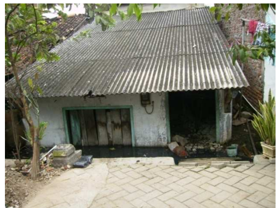
Gambar 2. Foto Kondisi Rumah di Kelurahan Kemijen yang terkena Rob
