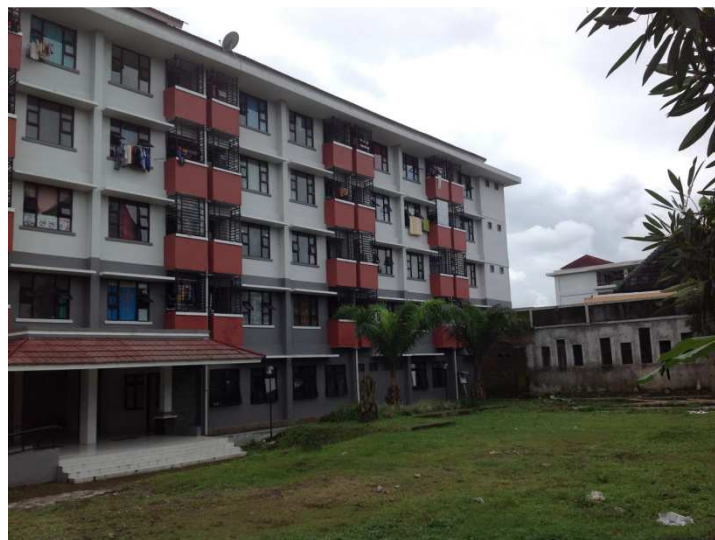
Gambar 8. Penggunaan elemen tritisan dan sunshading pada tampak bangunan Sumber: Survey Lapangan, 2015
