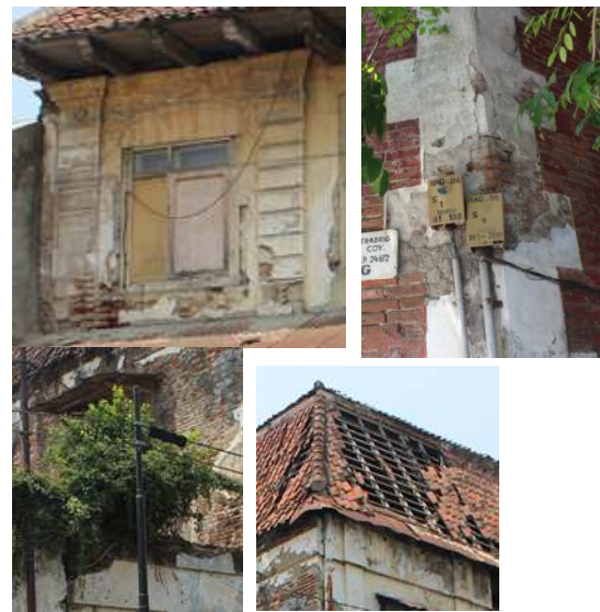
Gambar 5 Kerusakan pada fasade bangunan tidak difungsikan Sumber: Penulis (2015)
