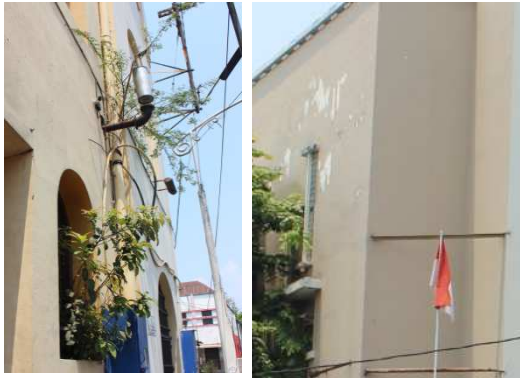
Gambar 3 Kerusakan bangunan difungsikan, karena iklim tropis lembab Sumber: Penulis (2015)
