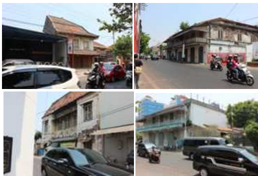
Gambar 4 Kondisi bangunan yang tidak difungsikan Sumber: Penulis (2015)
