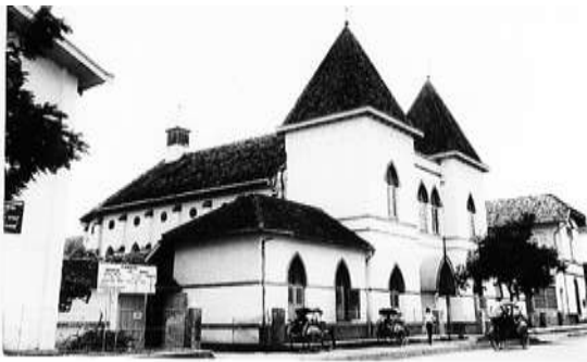
Gambar 2. Foto Bangunan Kapel Susteran Bangkang Semarang pada masa lalu (Sumber : Dokumentasi Jurusan Arsitektur FT Unika Soegijapranata)
