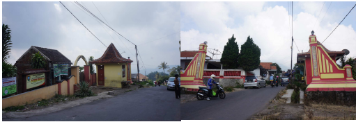
Gambar 01. Pembangunan gerbang masuk kawasan dan pos jaga
