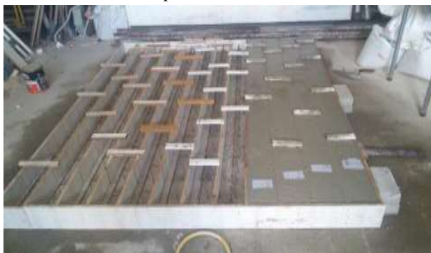
Fig.3: Enchimento das capas das vigotas pré-moldadas Fonte: Autor, 2018.
