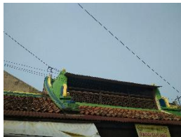
Gambar 14. Tampak Luar Lantai atas Bangunan ke-7
