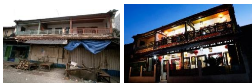
Gambar 11. Perbedaan Tampak Depan Bangunan ke-6 sebelum dan sesudah
