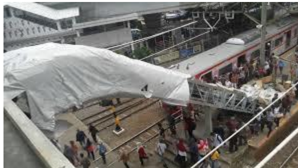
Kondisi Saat Pemasangan Elevator & Escalator di Proyek
