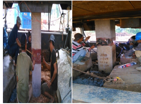
Gambar 9. Sambungan & Pengelasan
