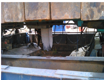
Gambar 12. Pengambilan sisa beton tiang pancang menggunakan crane
