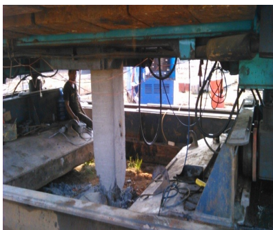
Gambar 11. Pemotongan sisa beton tiang pancang
