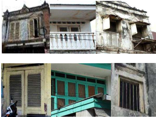
Gambar 11. Beberapa Bentuk Jendela Asli Bangunan di Kampung Arab Pekojan
