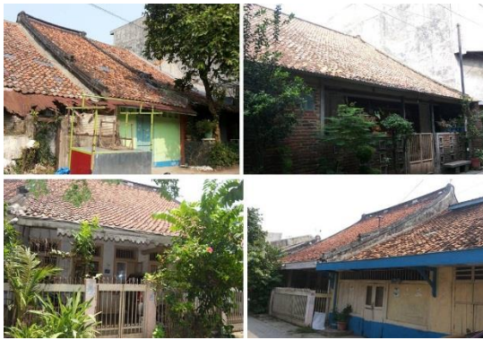
Gambar 15. Kondisi Eksisting Bangunan Khas Pecinan di Gang Kalipasir Sumber : Survei dan Dokumentasi Penulis, 2014
