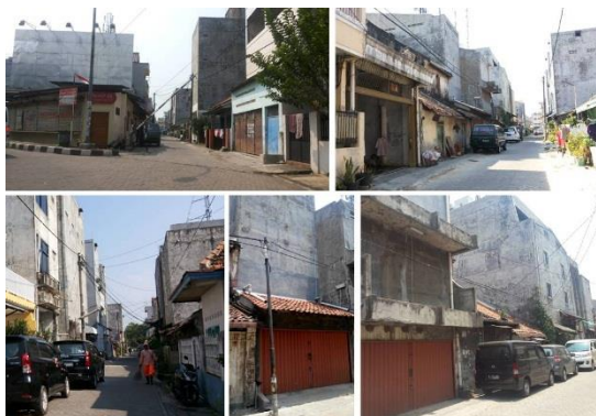
Gambar 12. Kondisi Eksisting Bangunan Budaya Walet di Gang Cirarab
