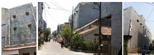
Gambar 8. Kondisi Eksisting Bangunan Budaya Walet di Gang Cilangkap Sumber : Survei dan Dokumentasi Penulis, 2014
