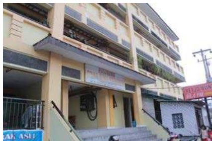
Gambar 2. Fasade depan Rumah Susun Juminahan, Yogyakarta.
