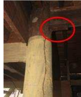
Gambar 10. Pasak untuk meperkuat ikatan balok dan kolom
