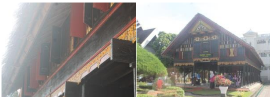
Gambar 17. Bukaan/ jendela di sisi utara selatan dan juga di sisi timur barat, tetapi jumlahnya hanya sedikit namun ditambah dengan ventilasi yang berbentuk ukiran yg dibolongi sehingga udara dan cahaya tetap bisa masuk.
