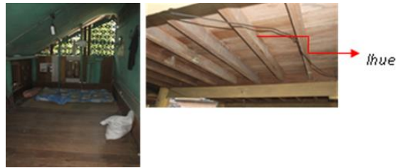
Gambar 14. Papan lantai yang dipaku pada balok lantai (Lhue)
