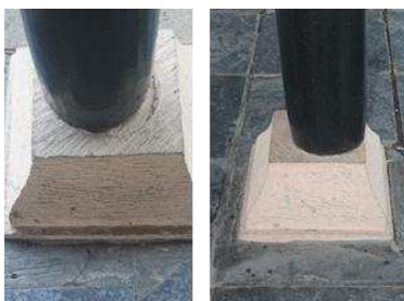
Gambar 13. Kolom yang bergeser akibat gempa yang terjadi di Aceh.
