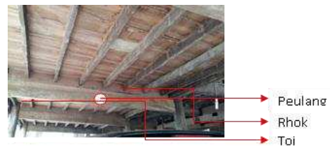
Gambar 11. Rhok, toi dan peulangan sebagai pengikat kolom
