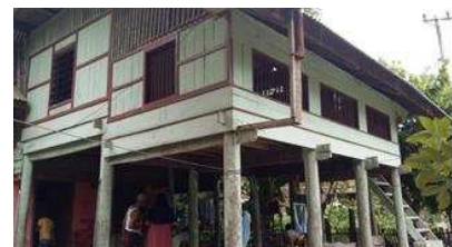
Gambar 26. Jendela yang terdapat pada setiap sisi rumah membuat cahaya dan aliran udara memenuhi setiap ruangan rumah.
