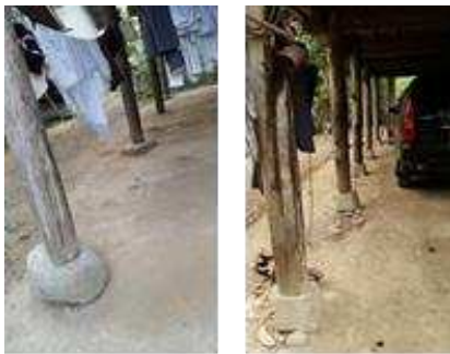
Gambar 9. Batu pondasi (kiri) dan pondasi beton (kanan) untuk menghindari kayu dari kelembaban tanah
