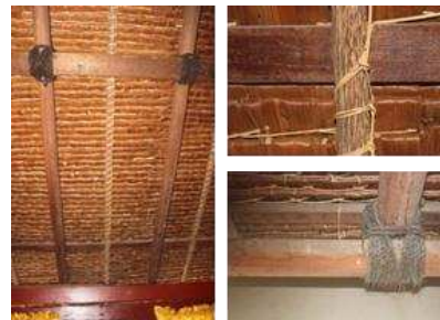
Gambar 19. Struktur atap yang ringan dengan material kayu dan daun rumbia serta diikat dengan tali ijuk dan rotan
