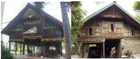
Gambar 3. (kiri) Rumah Aceh tanpa rumah bawah/tumbuh (Kanan) Rumah Aceh dengan rumah bawah/tumbuh
