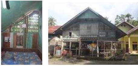
Gambar 16. Bukaan pada Rumoh Aceh yang berfungsi untuk mengalirkan udara dan memasukkan cahaya
