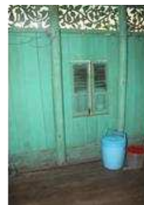
Gambar 15 Papan dinding yang dipasang secara horizontal
