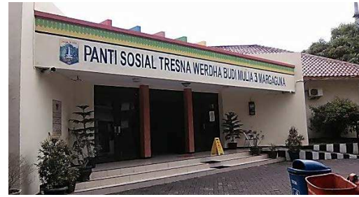
Gambar 1. Bangunan Lama Panti, 1 Lantai Sumber: Dokumentasi Pribadi (2015)
