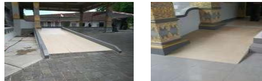
Gambar 6. (a) Ram Di Luar Bangunan; (b) Ram Menuju Pintu Utama
