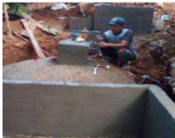
Gambar 3. Pembuatan Katup Pengaman Tekanan
