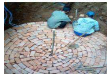
Gambar 2. Pembuatan Dasar Sumur ‘Biogas’
