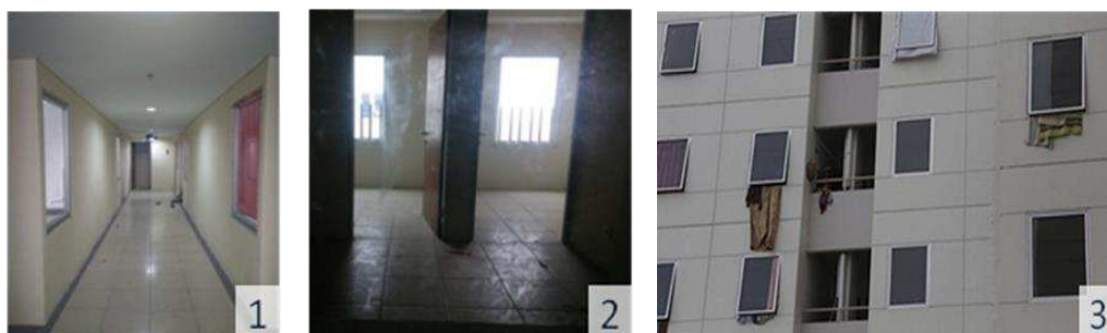
Gambar 5. Foto Interior dan Eksterior Rusunawa Jatinegara Barat terkait Bukaannya
