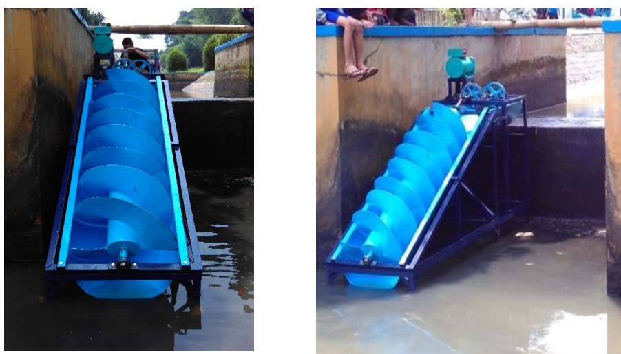
Gambar 9. Proses Pemasangan dan Pengujian Turbin di Lokasi
