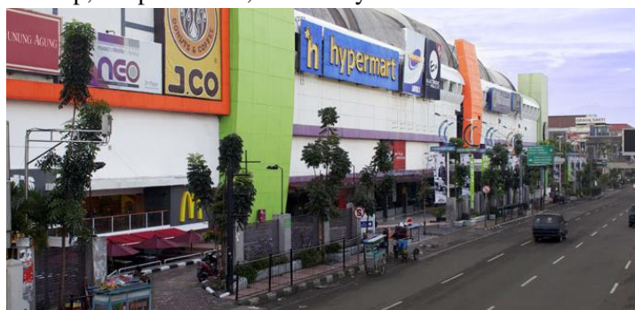
Gambar 6. Tampak depan Bandung Indah Plaza[9]
